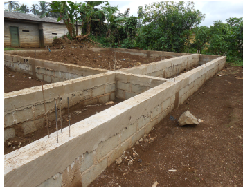
Vue de la fondation
