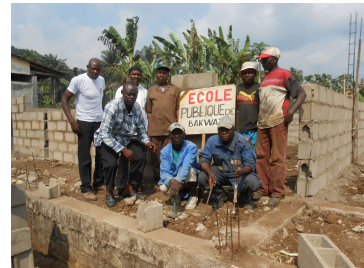
Travaux de l'élévation
