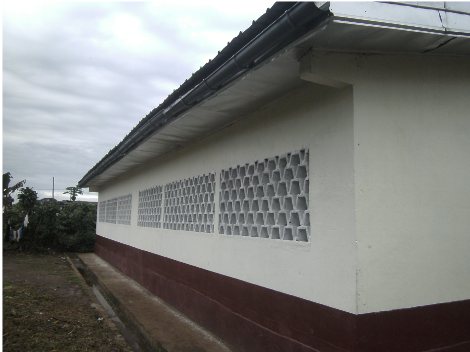
Vue de la façade arrière
