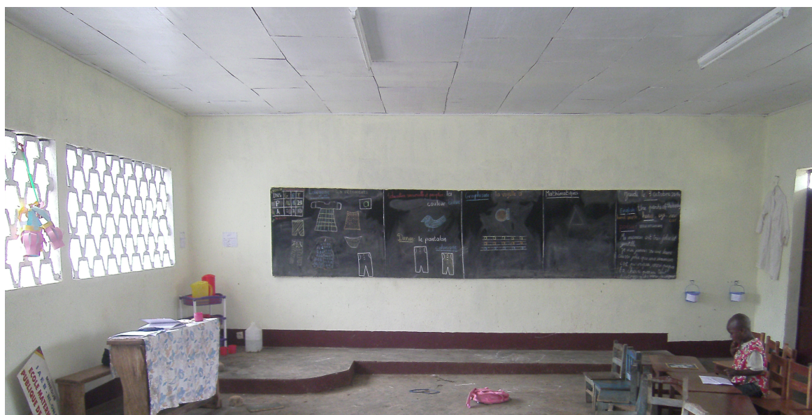
Vue finale intérieure de l'école
